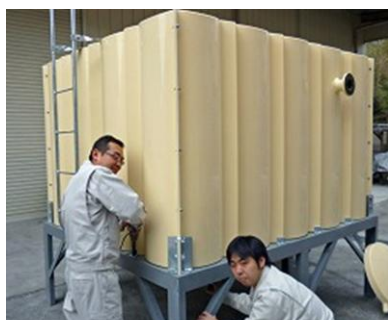
架台取り付け作業中
