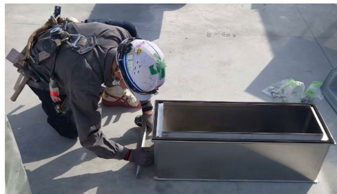
①台座を仮置きし墨出し。
