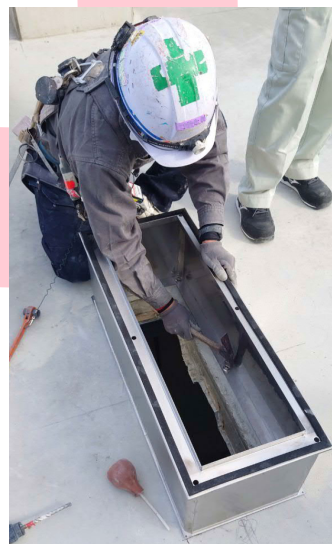
④アンカーの施工。
